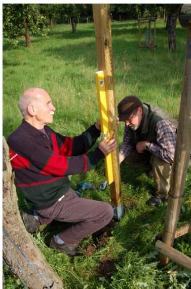
Pfostenausrichtung
