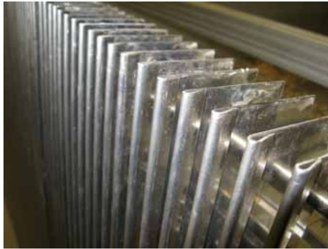
Abbildung 1 Ansicht der Oberkante des Oppermann-Rechens
