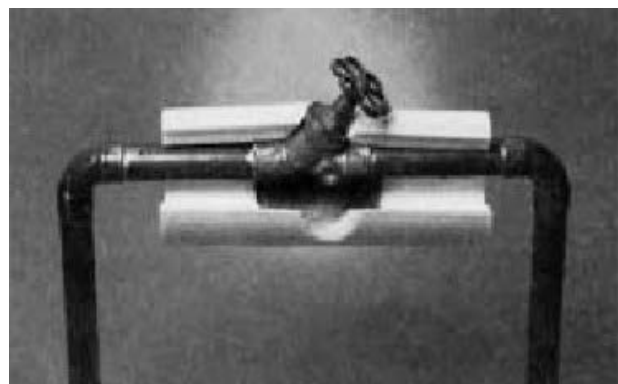
Dämmung einer Verteilleitung
