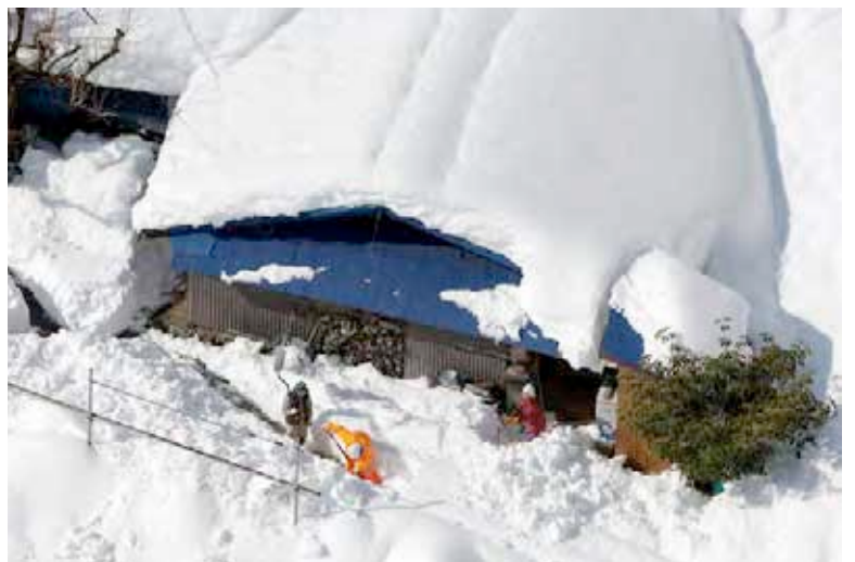
In Japan brachten Schneemassen den Verkehr weiträumig zum Erliegen. Folgenreicher war die hohe Schneelast auf den Dächern – nicht überall waren diese auf das Gewicht vorbereitet und brachen ein.
