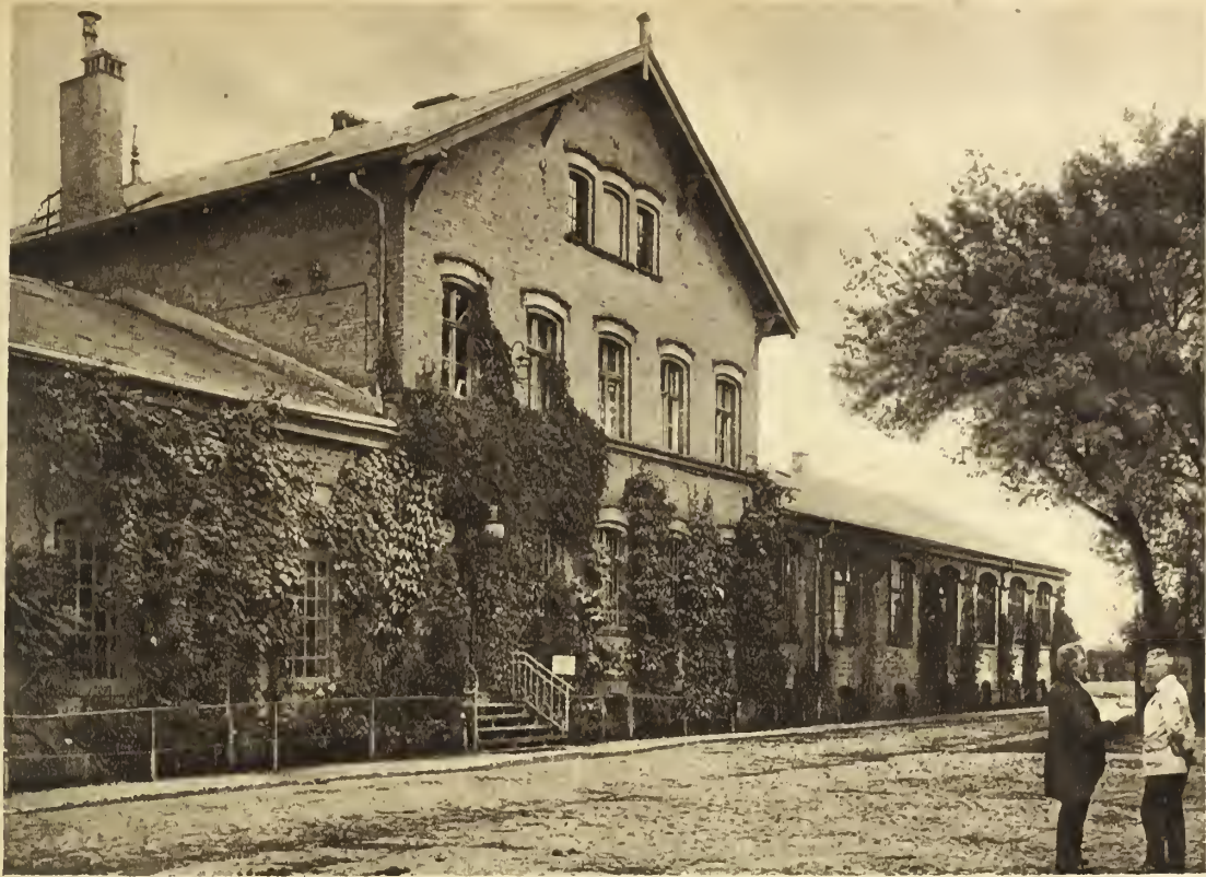
Bürogebäude in Baumschulenweg.
