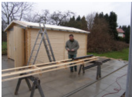
oben: Montage der Traufen- und Giebelbretter unten: 28.03. Montage Regenrinne und Dachpappe
