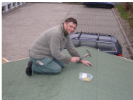
oben: Montage der Traufen- und Giebelbretter unten: 28.03. Montage Regenrinne und Dachpappe
