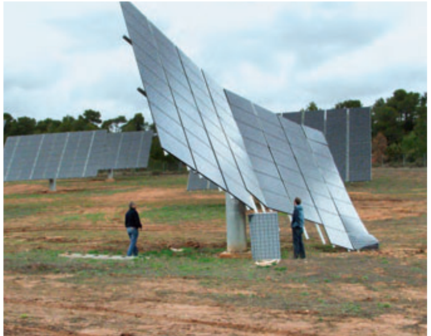
Wintersturm Klaus zeigte die Exponierung von neuen Risiken wie Solaranlagen auf. In Spanien überstiegen die Sturmschäden an den Anlagen bei Weitem die Jahresprämie dieser Risiken. Die Aufnahme zeigt den Schaden an einer Photovoltaikanlage nahe Barcelona.
