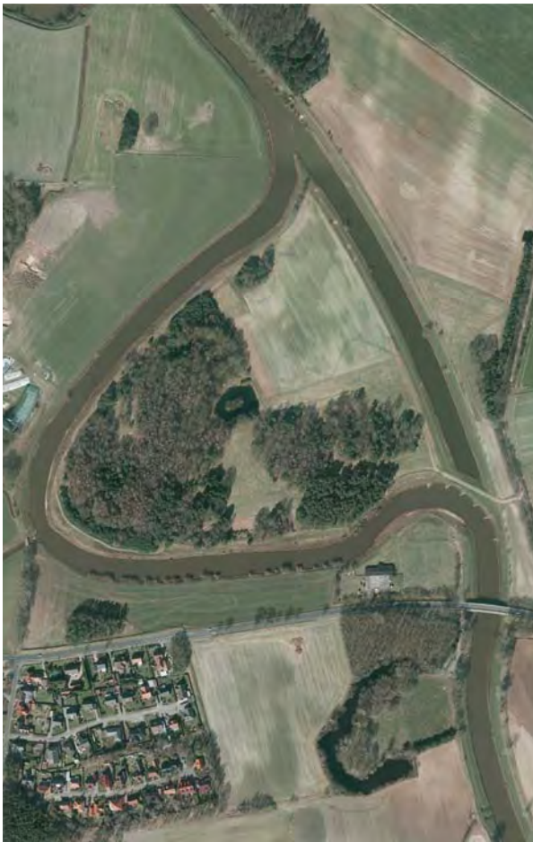
≈ Altarmanschlüsse an der Hase bei Lahre. Die durch die Begradigung abgetrennte Flussschlinge ist nun wieder an den Fluss angebunden und gleichzeitig entstanden naturnahe Ufer- und Auenbereiche.
