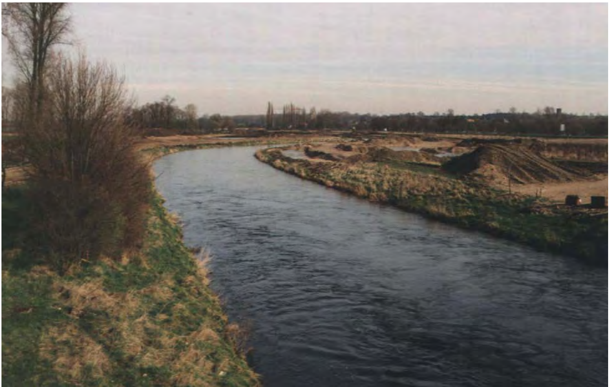
≈ Begradigte Rur bei Körrenzig zu Beginn der Maßnahmenumsetzung
