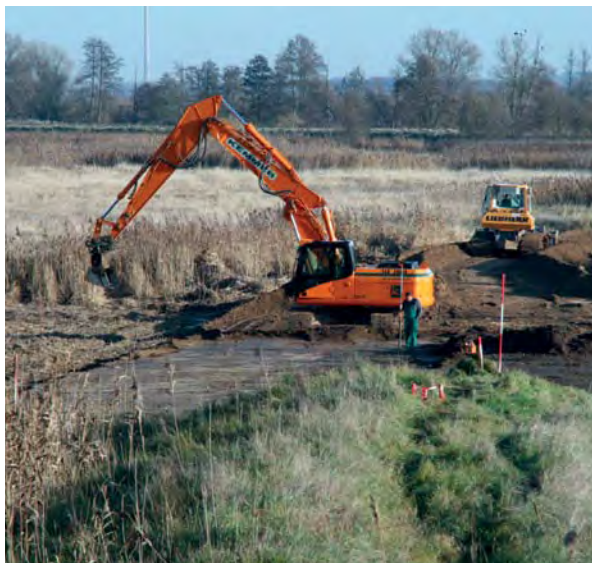
≈ Bauarbeiten zur Schlitzung des Deiches am Staffelder Polder im Jahr 2008
